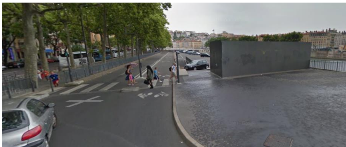
Parking vélo sécurisé Saint-Jean (Lyon 5). Capacité 40 places
