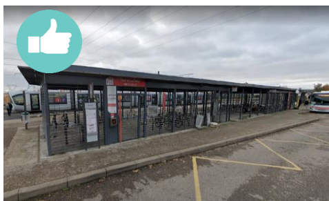
Parking-relais vélo à la station Meysieu Z.I. : le tramway est aussi un pôle d'intermodalité.
