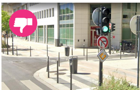
Rue Garibaldi : une piste cyclable ponctuée de nombreux franchissements de bordures à chaque carrefour.
