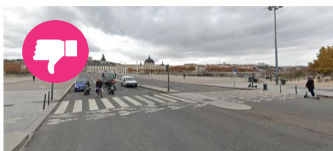
Quai Victor Augagneur : piétons et cyclistes se mélangent dans une traversée unique. En outre, le stockage à mi-parcours se fait dans un minuscule sas très accidentogène.
