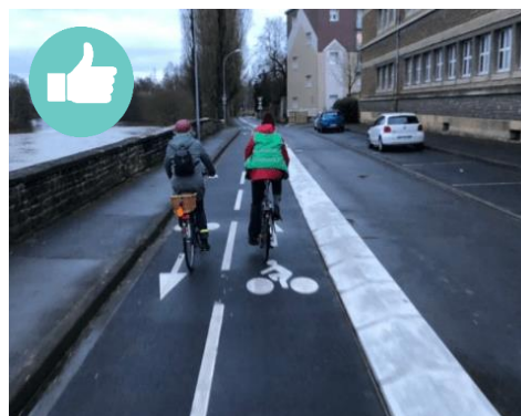
Une bordure pardonnante marque une délimitation claire entre les usagers tout en ne créant aucun danger ou obstacles.
